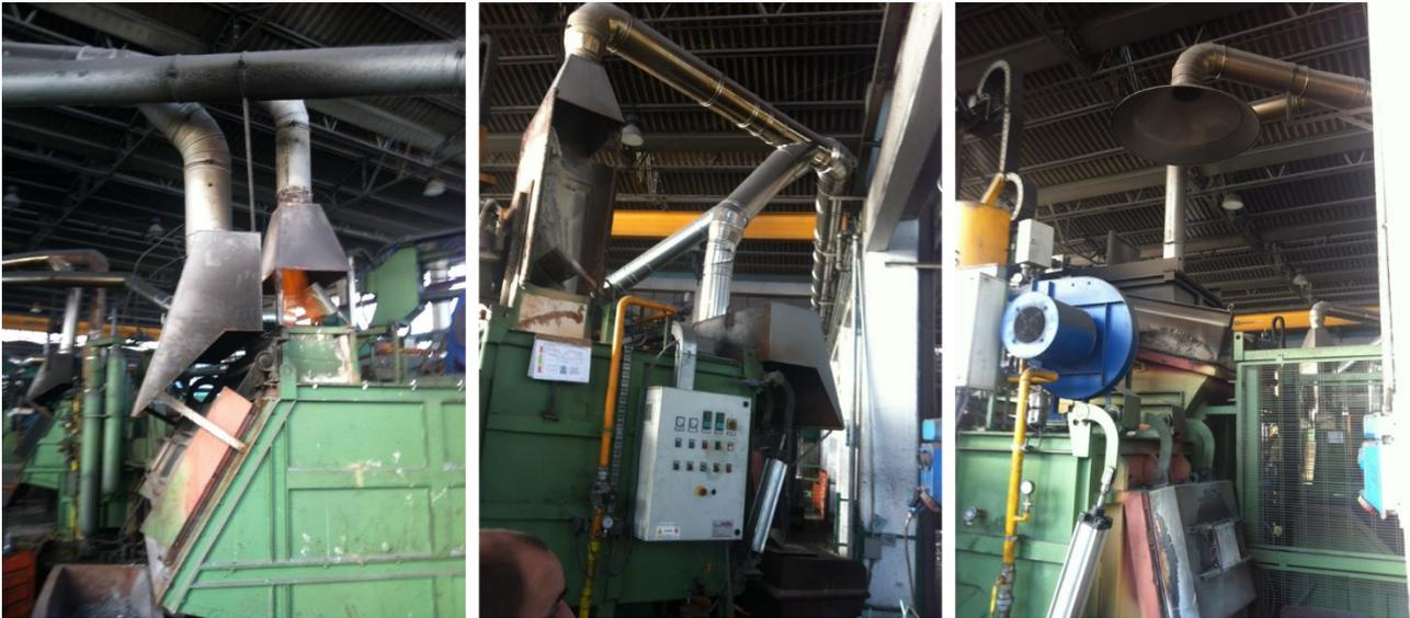
Figura 8. Impianto di aspirazione: cappe sui forni e in punti di lavorazione
