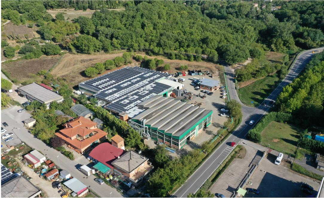
**Figura 24 La copertura dopo l'istallazione dei pannelli fotovoltaici (2016)**
